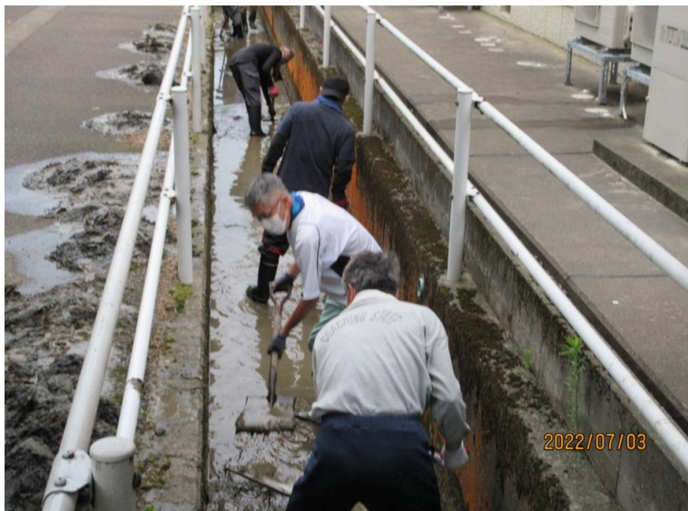
第2町内；川底の土砂上げ
